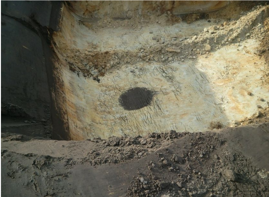
Afbeelding 5.5. Inslagopening van één van de bommen die door de EODD zijn opgegraven. Foto: B. Stielstra, Leemans Speciaalwerken, Vriezenveen.
